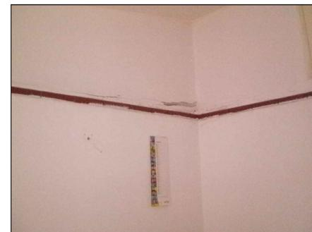
Foto n° 16: parete con infiltrazioni di umidità
